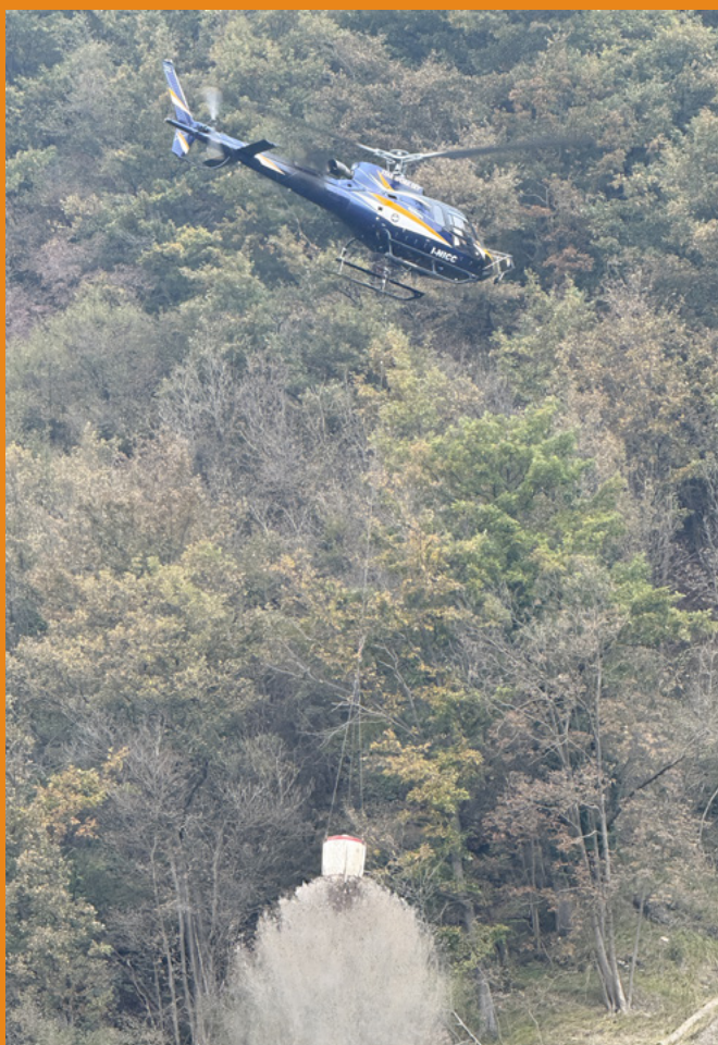
Operazioni di idrosemina su versante eseguite con elicottero.
