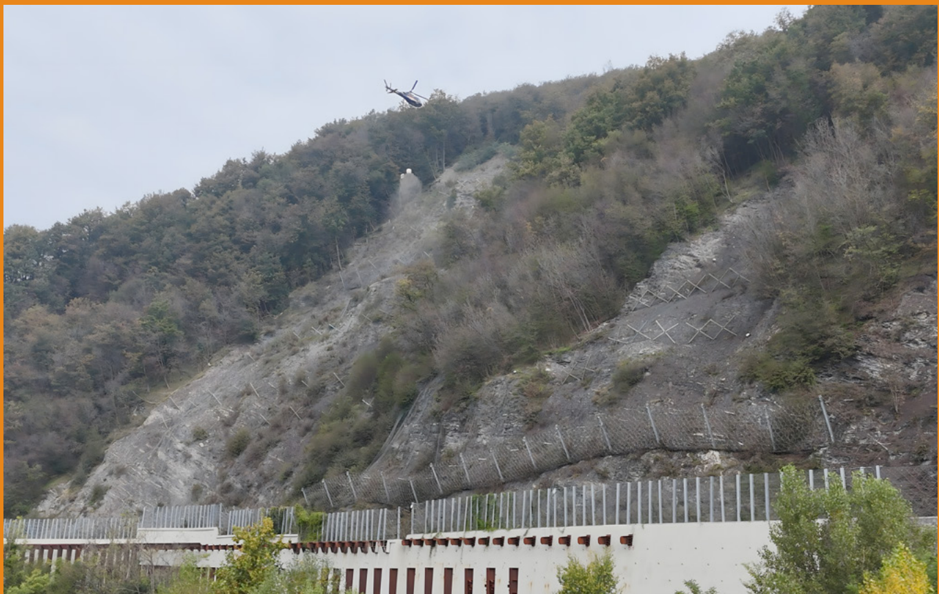
Operazioni di idrosemina su versante eseguite con elicottero.
